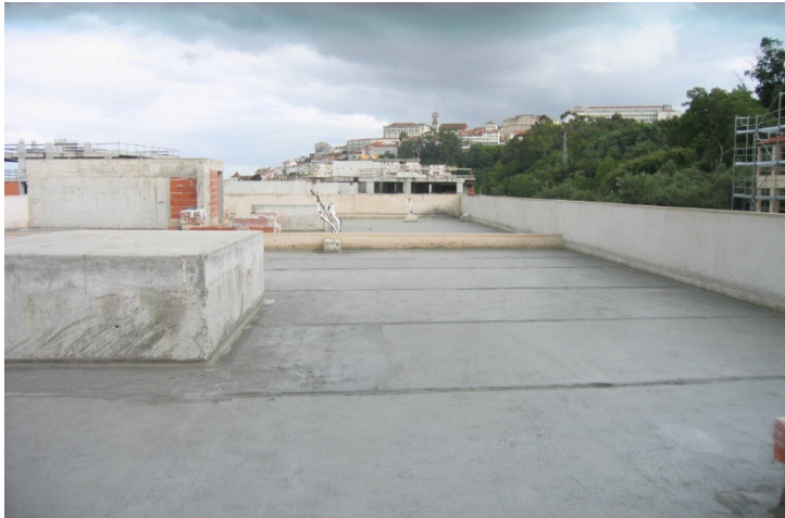
Figura2: Camada de regularização
